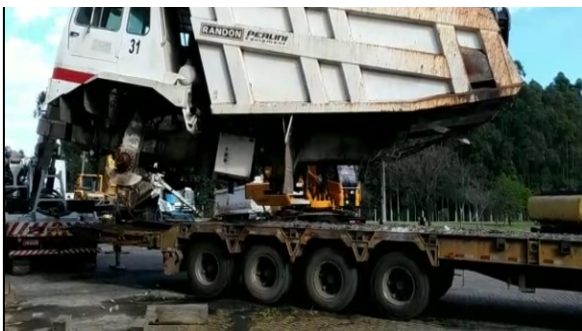
Figura XX – Remoção dos maquinários existentes na parte externa da oficina mecânica, sendo realizada entre os dias 9 e 11/10/2019.
