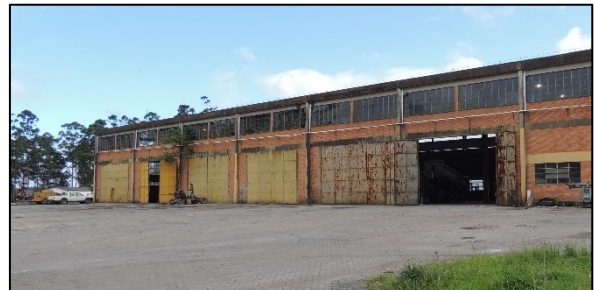
Figura XX – Imagem da parte externa da oficina mecânica, já sem os maquinários (OUT/2019).
